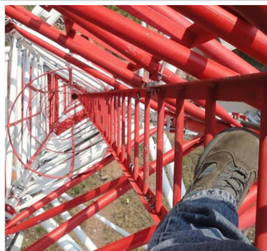
Vista escalerilla de ascenso
