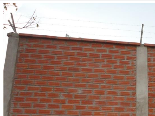
Cerramiento de ladrillo visto
