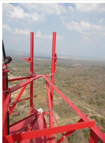
Soportes para Antena RF
