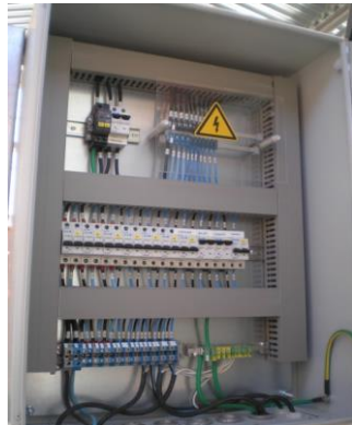
FOTO 7 VISTA TABLERO DE DISTRIBUCION PRINCIPAL
